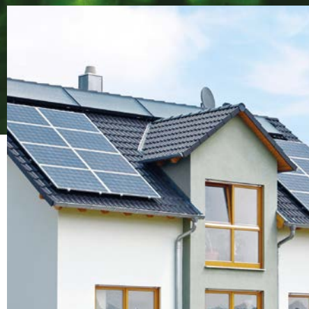
FOTÓVOLTAIKUS MODULOK ÉS INVERTEREK
